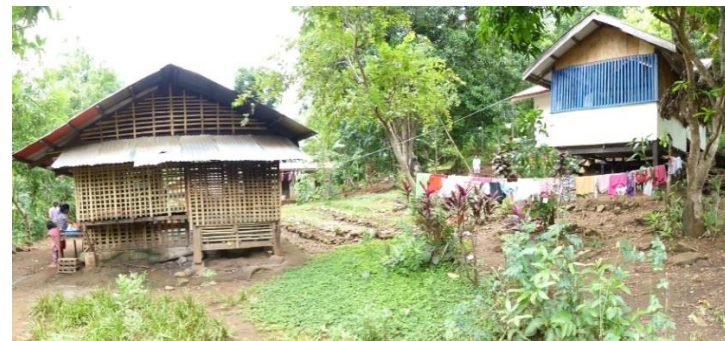
Auf dem freien Platz zwischen den Gebäuden wird die neue Hütte gebaut
