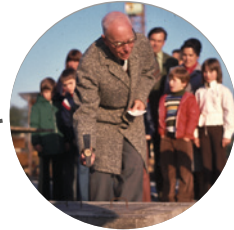
Prof. Reininghaus Grundsteinlegung Königsträßle → 1976
